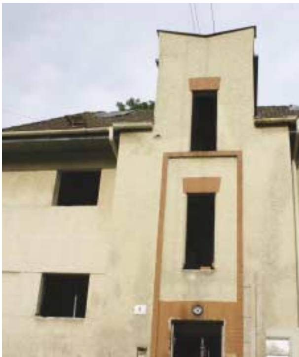
Revitalisierung des Altbestandes: nur die Gebäudeaußenhülle bleibt bestehen
